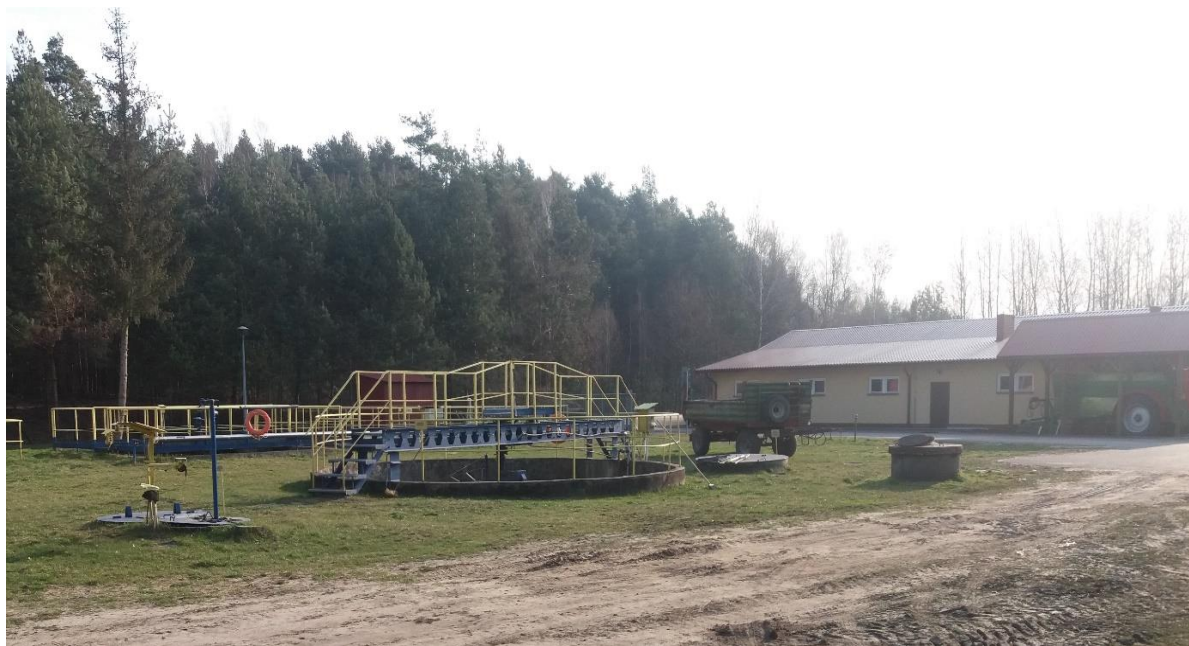
Oczyszczalnia ścieków w Majdanie Królewskim
