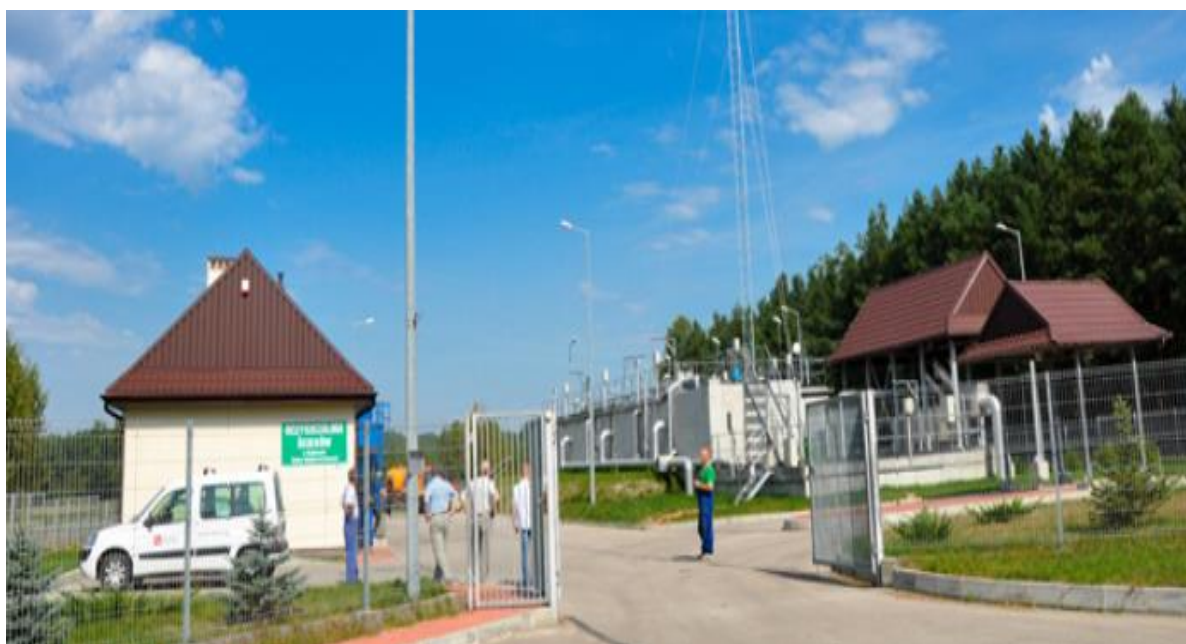
Oczyszczalnia ścieków w Rusinowie
