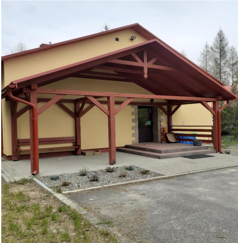
Budynek socjalno-techniczny przy oczyszczalni ścieków w Majdanie Królewskim po termomodernizacji.
