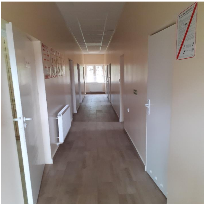
Wyremontowane pomieszczenia budynku socjalno-technicznego.
