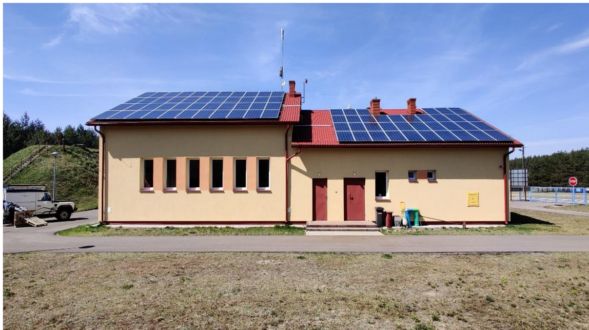
Istniejące panele fotowoltaiczne na budynku ujęcia wody w Hucie Komorowskiej.
